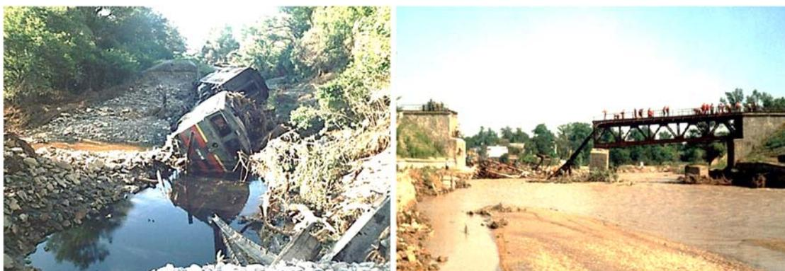
Рисунок 1. Размыв земляного полотна на перегоне Суворовская–Нагутская (слева), разрушение моста через реку Подкумок (справа)
