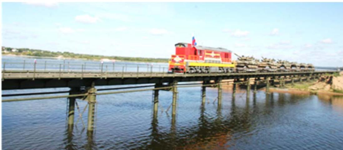
Рисунок 7. Пропуск по ИМЖ-500 поездной нагрузки
