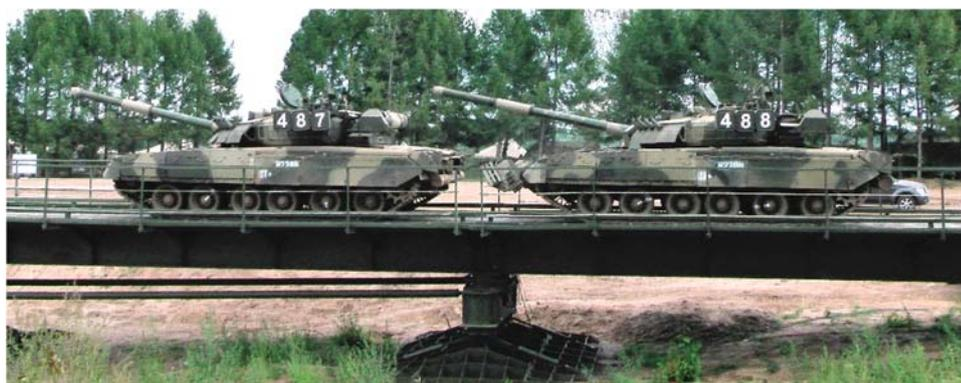
Рисунок 9. Пропуск по ИМЖ-500 гусеничной нагрузки (НГ-60)
