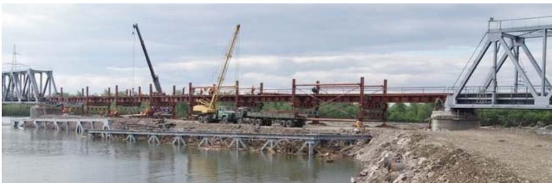
Рисунок 5. Восстановление моста через реку Абакан с монтажом эстакады РЭМ-500
