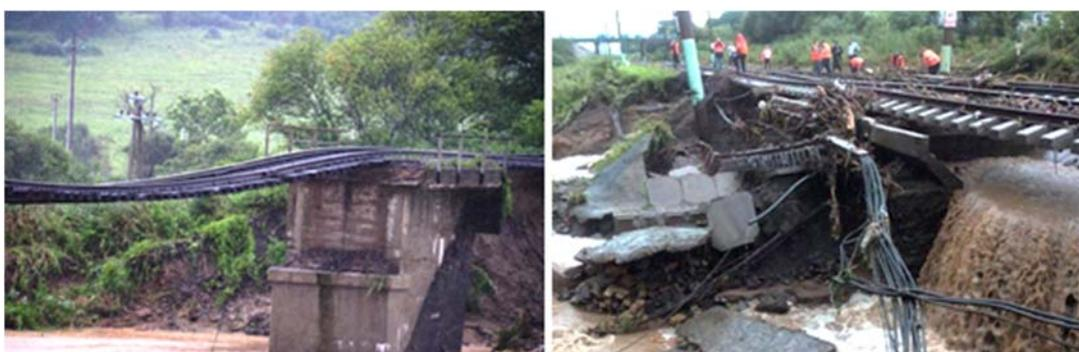
Рисунок 4. Мосты, разрушенные на Дальневосточной железной дороге в 2017 г.
