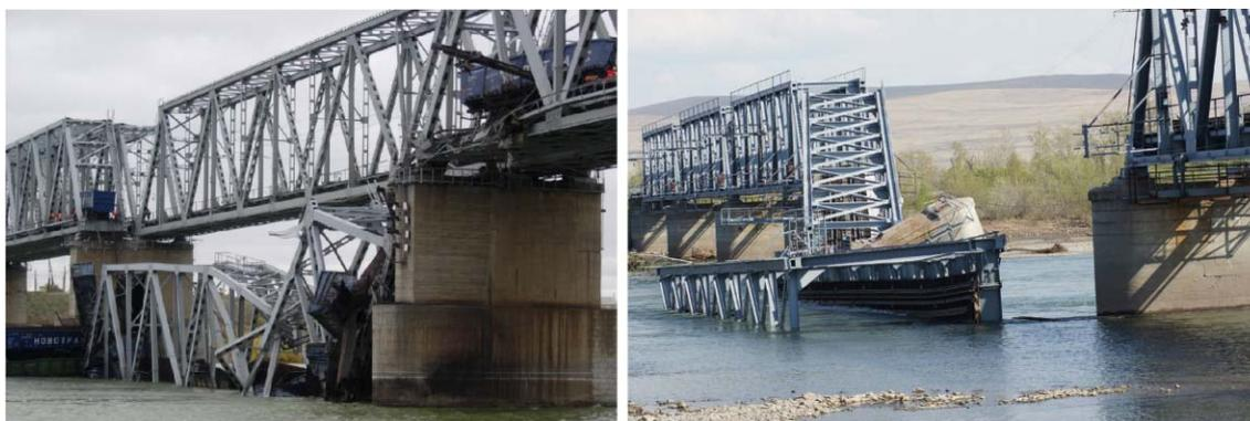
Рисунок 2. Разрушение пролётного строения моста через реку Иртыш у Омска (слева), частичное разрушение моста через реку Абакан (справа)
