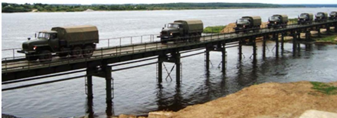
Рисунок 8. Пропуск по ИМЖ-500 автомобильной нагрузки (А-11)
